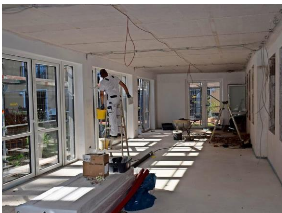
Im Wintergarten sind die Maler am Arbeiten. Quelle: Anette Wulf-Dettmer
