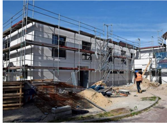
In diesen zweigeschossigen Neubau am Marris-Mühlenweg wird im Erdgeschoss der moderne Küchenbereich eingebaut. Darüber liegen die neuen elf Zimmer für die Senioren. Quelle: Anette Wulf-Dettme
